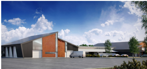
CC Loire Aubance - création d'un centre technique
