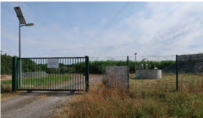
Station d'épuration plantée de roseaux à Saint-Martin-du-Fouilloux
