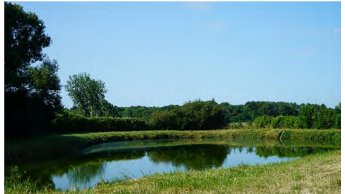
Station d'épuration de lagunes à Sarrigné
